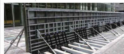
高さ1.7mの防潮板
