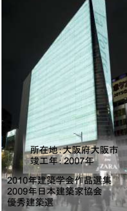
La Porte 心斎橋
