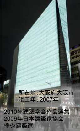
La Porte 心斎橋
