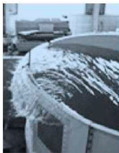
受水槽のスロッシング
