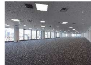
柱の無いフレキシブルな執務空間
