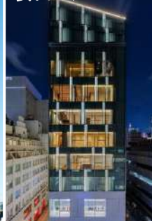
銀座松屋通り 安田ビル
